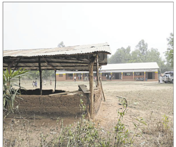
Der Blick durch ein marodes Schulgebäude auf den Neubaun.
