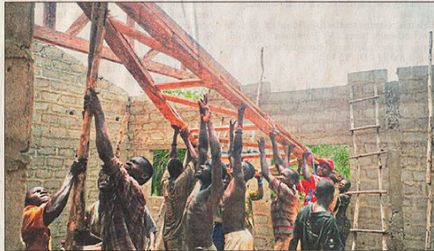
Eine Dachkonstruktion wird mit vereinten Kräften angebracht.
